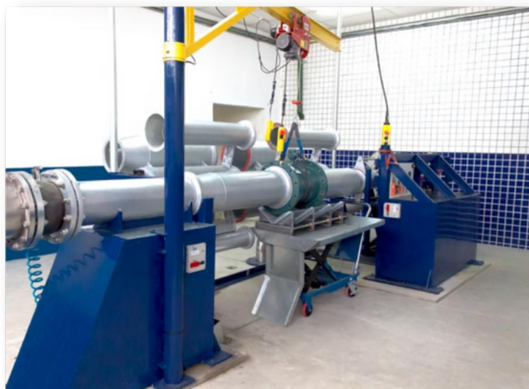
Laboratório de Alta Vazão
